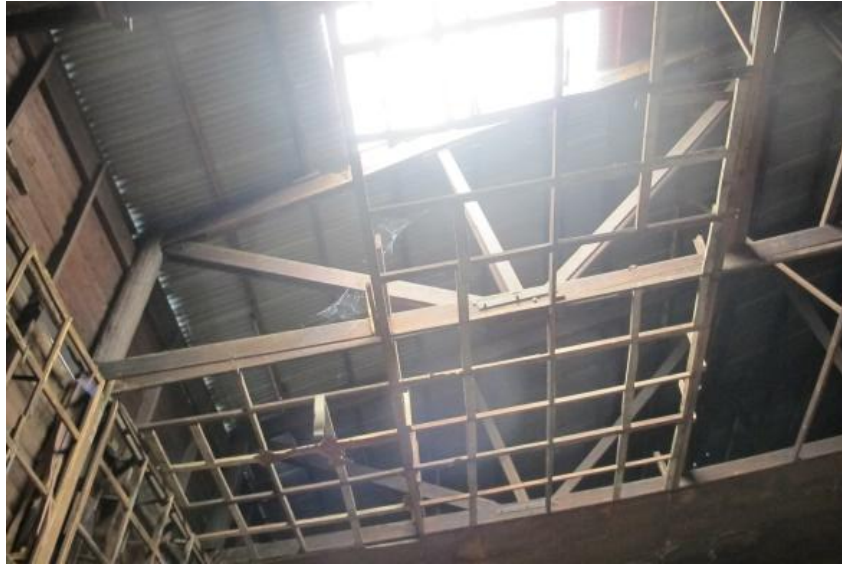
รูปที่ ๔-๑๕ : โครงสร้างหลังคาแบบถัก (Truss) ที่ทำให้พื้นที่อาคารขยายออกไปได้กว้าง (ที่มา : จากการสำรวจเก็บข้อมูลเดือนมกราคม ๒๕๕๘)
