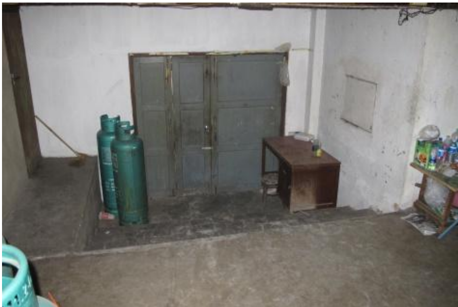
รูปที่ ๔-๑๒ : ทางเข้าด้านข้างภายในอาคารศาลาเฉลิมธานีซึ่งขาดการระมัดระวังเรื่องความปลอดภัย (ที่มา : จากการสำรวจเก็บข้อมูลเดือนมกราคม ๒๕๕๘)
