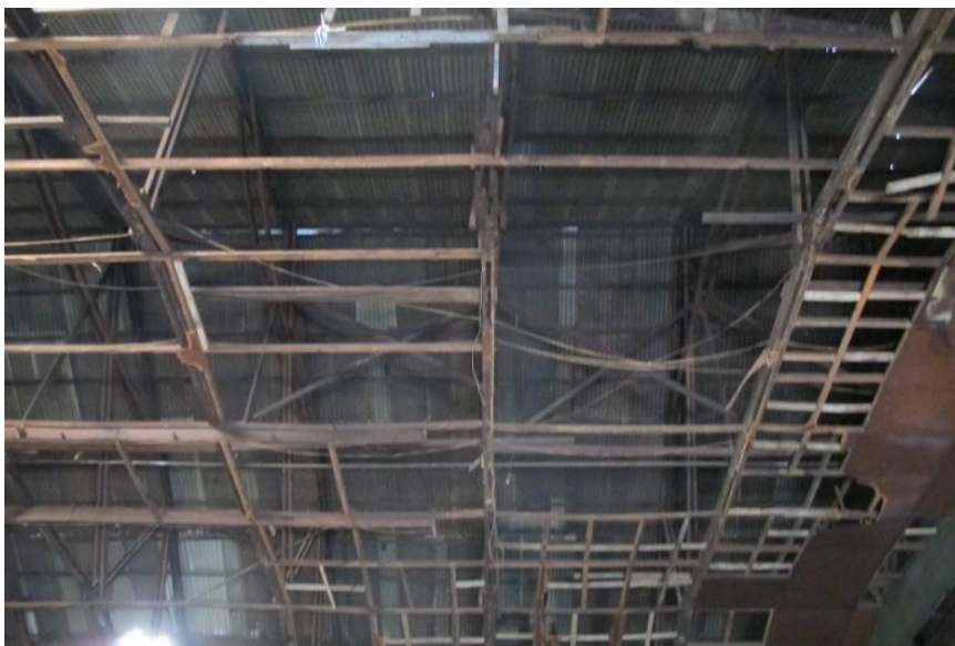
รูปที่ ๔-๑๖ : โครงสร้างหลังคาแบบถัก (Truss) ที่คลุมด้วยสังกะสี (ที่มา : จากการสำรวจเก็บข้อมูลเดือนมกราคม ๒๕๕๘)
