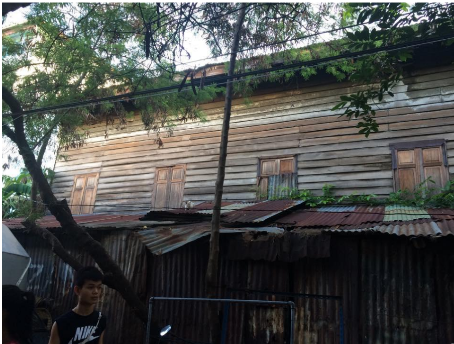
รูปที่ ๔-๙ : สภาพด้านข้างอาคารศาลาเฉลิมธานี (ที่มา : จากการสำรวจเก็บข้อมูลวันที่ ๓๑ มีนาคม ๒๕๕๘)
