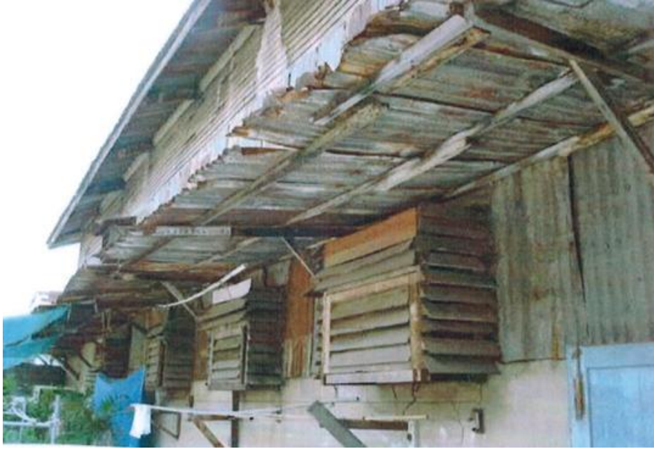
รูปที่ ๓-๗ : บริเวณช่องระบายอากาศด้านข้างอาคารเฉลิมธานี (ที่มา : เอกสารจากสำนักงานทรัพย์สินส่วนพระมหากษัตริย์)
