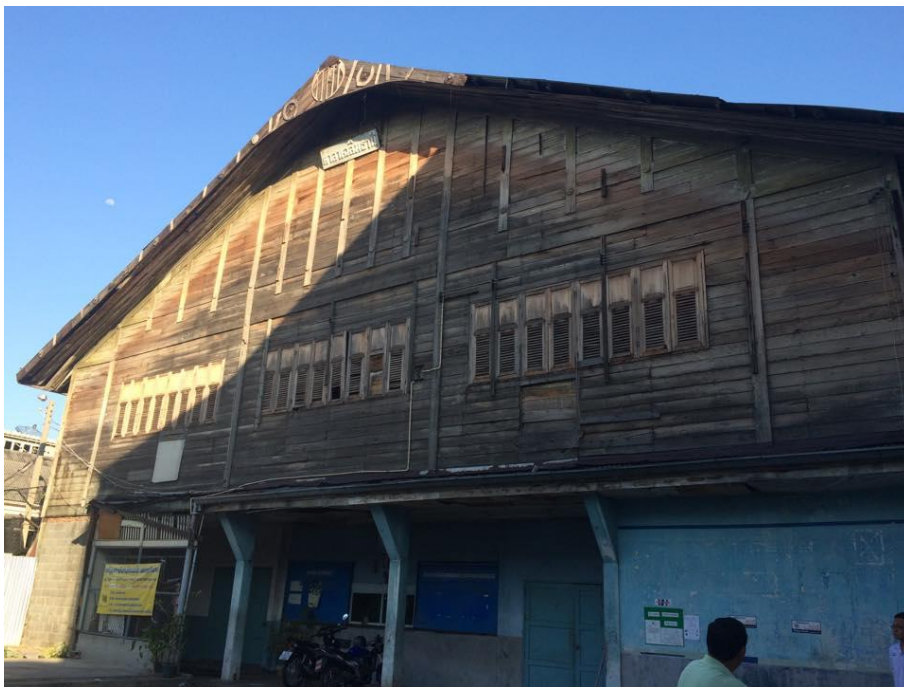
รูปที่ ๔-๗ : สภาพด้านหน้าอาคารศาลาเฉลิมธานี (ที่มา : จากการสำรวจเก็บข้อมูลวันที่ ๓๑ มีนาคม ๒๕๕๘)
