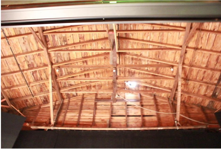
รูปที่ ๒-๘๙ :โครงสร้างหลังคาไม้ด้านบนของเวที เปลี่ยนให้เห็นองค์ประกอบที่มีความงาม ไม่มีฝ้าบุและไม่มี การซับเสียง แต่เสียงที่ได้ยินจากการฉายนั้นมีความสมบูรณ์มาก (ที่มา: จากการเก็บข้อมูลวันที่ ๑๕ พฤษภาคม ๒๕๕๘)
