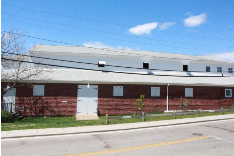
รูปที่ ๒-๘๓ : หน้าต่างด้านบนและล่างสามารถเปิดเพื่อรับลมระบายอากาศ ทำให้อากาศถ่ายเทได้ (ที่มา: จากการเก็บข้อมูลวันที่ ๑๕ พฤษภาคม ๒๕๕๘)
